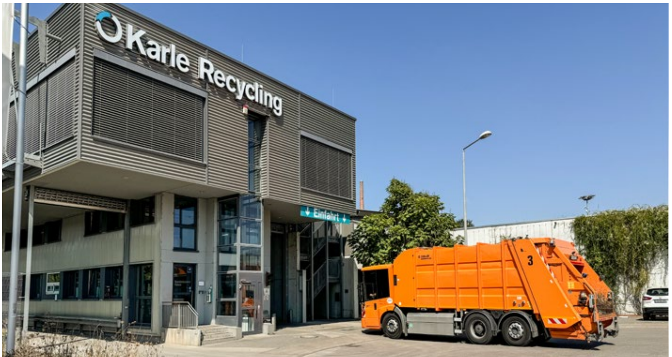
Pro Tag fahren mehrere Fahrzeuge der AWS den Sperrmüll zu Karle Recycling.
